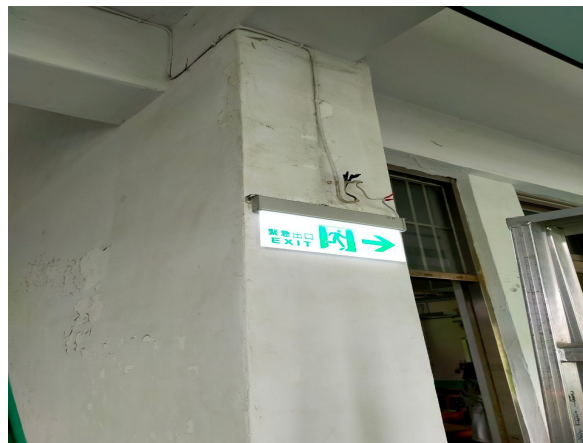
避難方向指示燈更換施工完成
