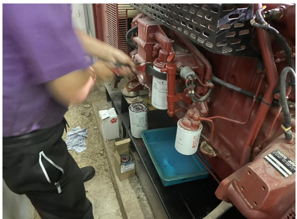
引擎機油濾清器更換施工
