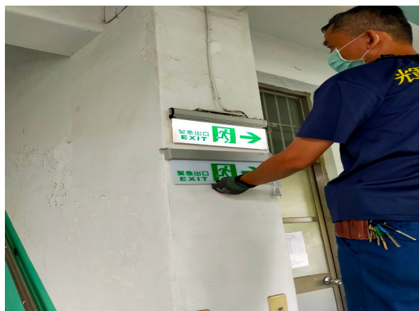
避難方向指示燈更換施工前對照
