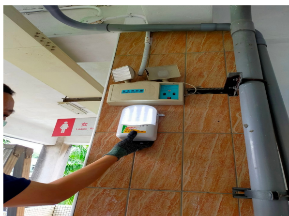
緊急照明燈更換施工前對照
