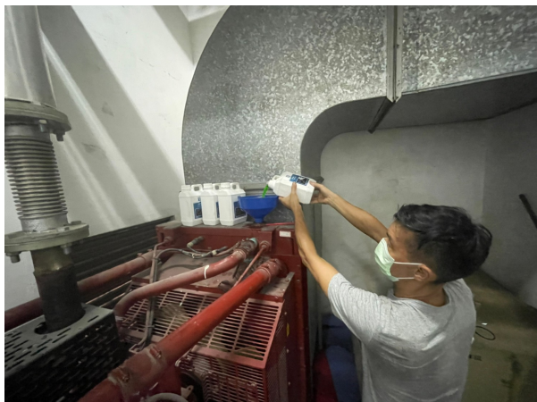
冷卻水箱精添加施工
