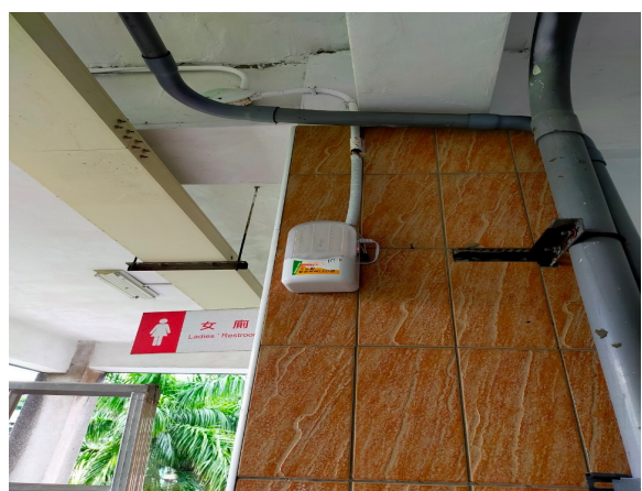
緊急照明燈更換施工完成
