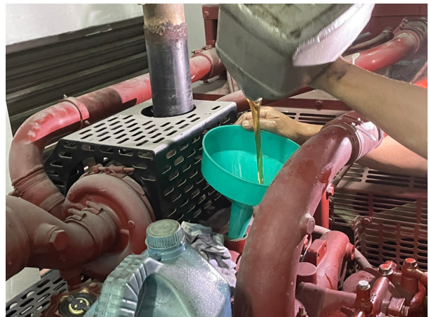
引擎機油添加施工
