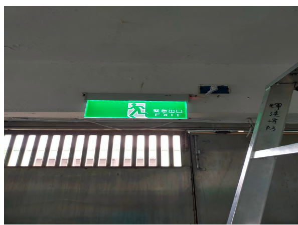
出口標示燈更換施工完成
