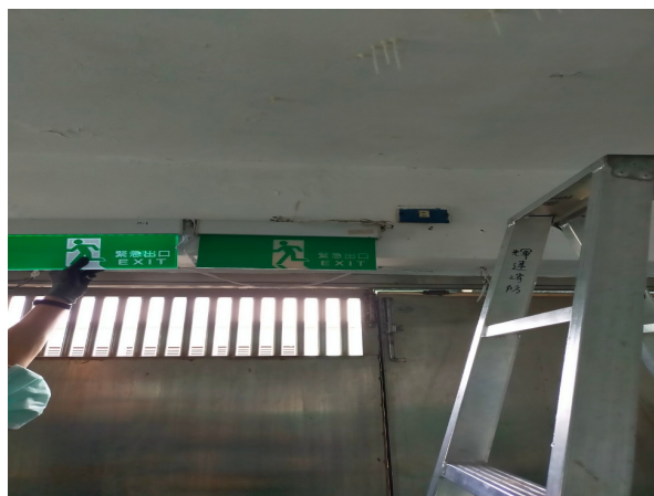
出口標示燈更換施工前對照
