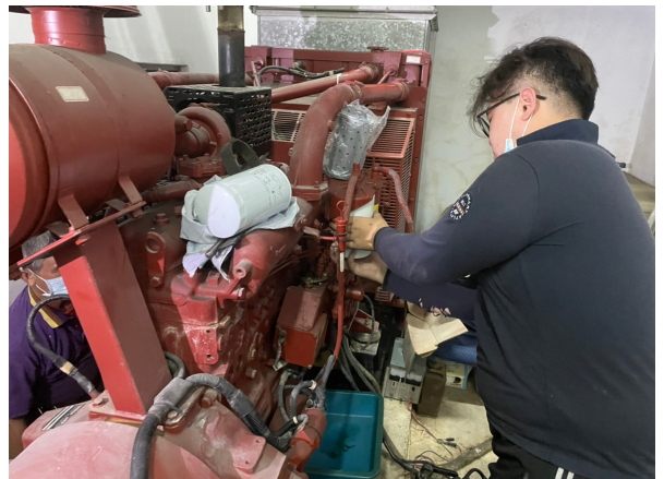
柴油濾清器更換施工
