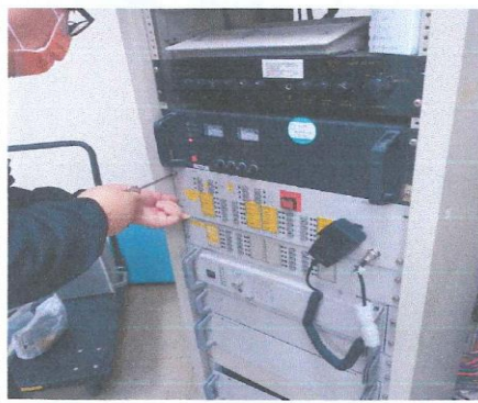
緊急廣播主機查修完成安裝施工
