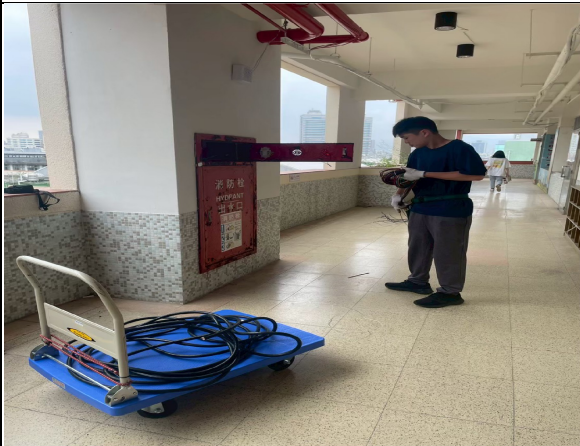
各層分區火警幹線抽換施工中
