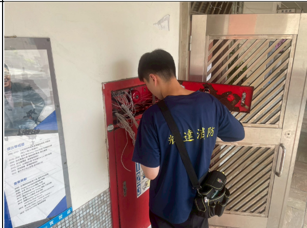
火警幹線與綜合盤內設備連結施工中-1
