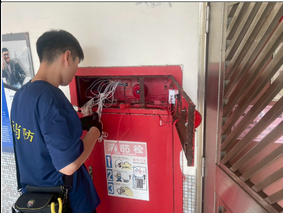
火警幹線與綜合盤內設備連結施工中-2
