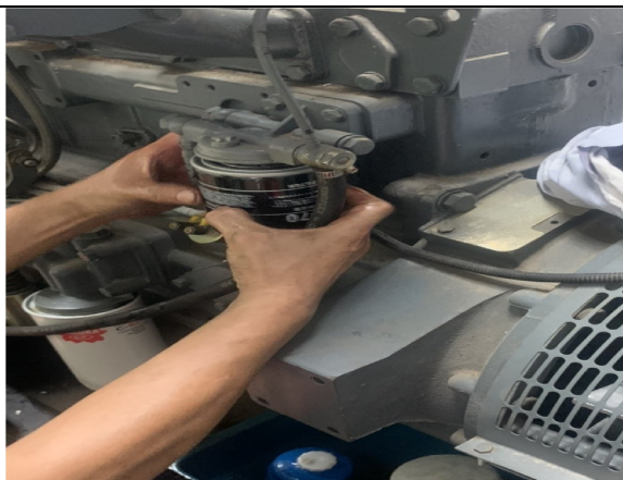
發電機組濾清芯子更換施工中
