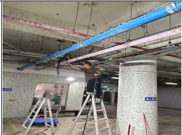
各棟火警主幹線抽換配置施工中-2
