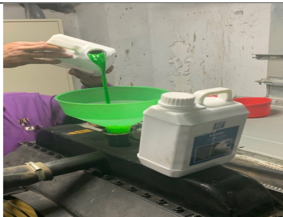
冷卻水箱水更換施工中
