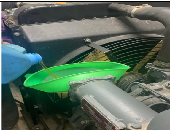
引擎機油更換施工中
