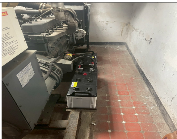
啟動電瓶更換施工完成
