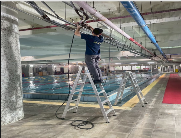
各棟火警主幹線抽換配置施工中-1
